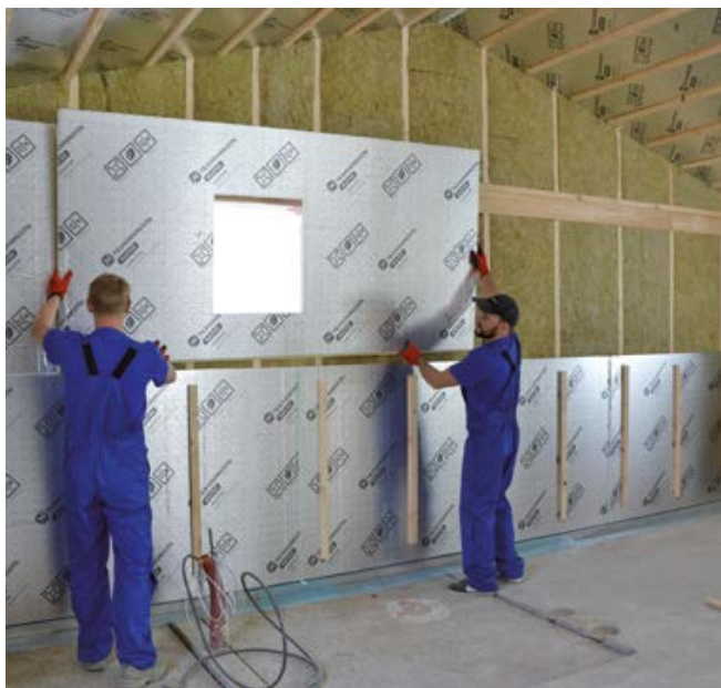
Контрутепление стен
