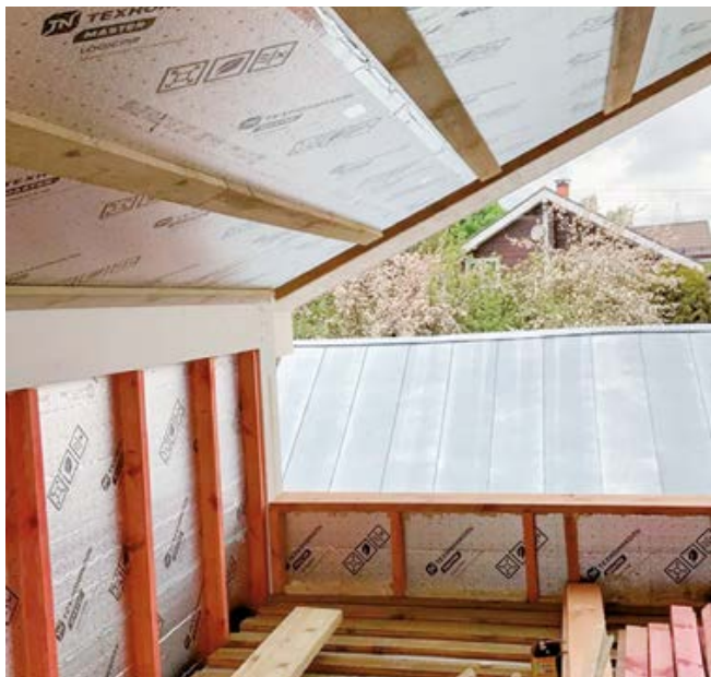
Контрутепление скатной кровли
